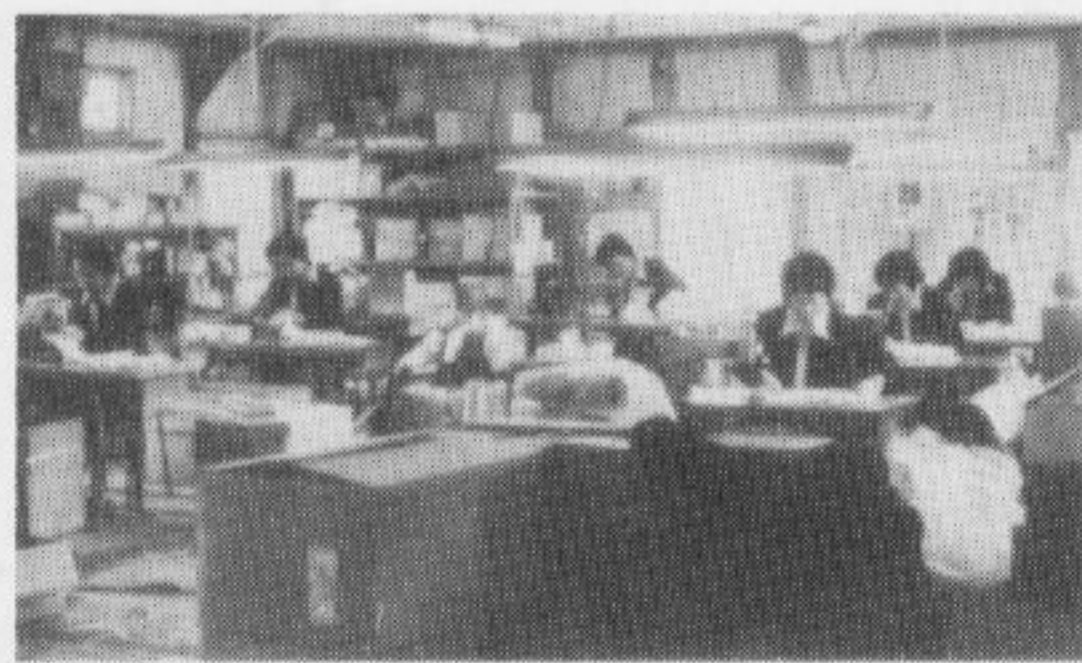
工場内作業風景
