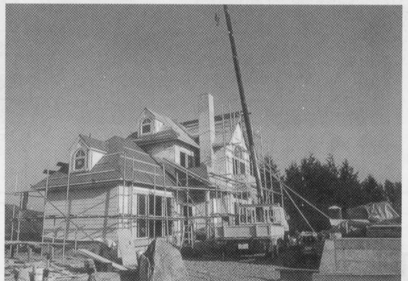
建設中の輸入住宅
