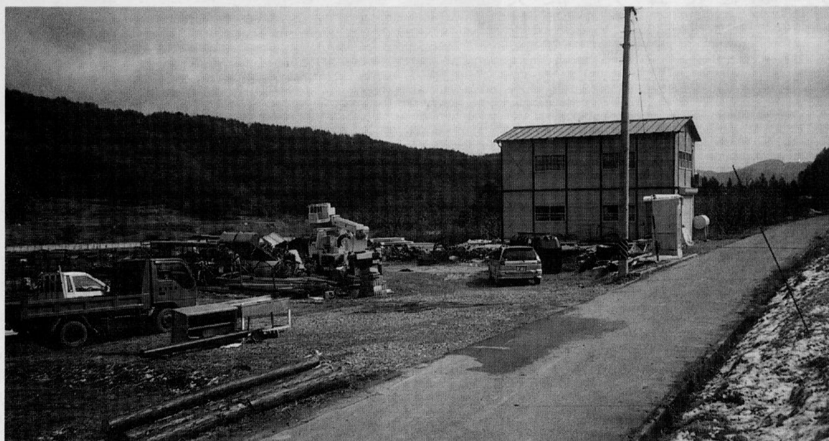
曾山地区にある倉庫と資材置場
