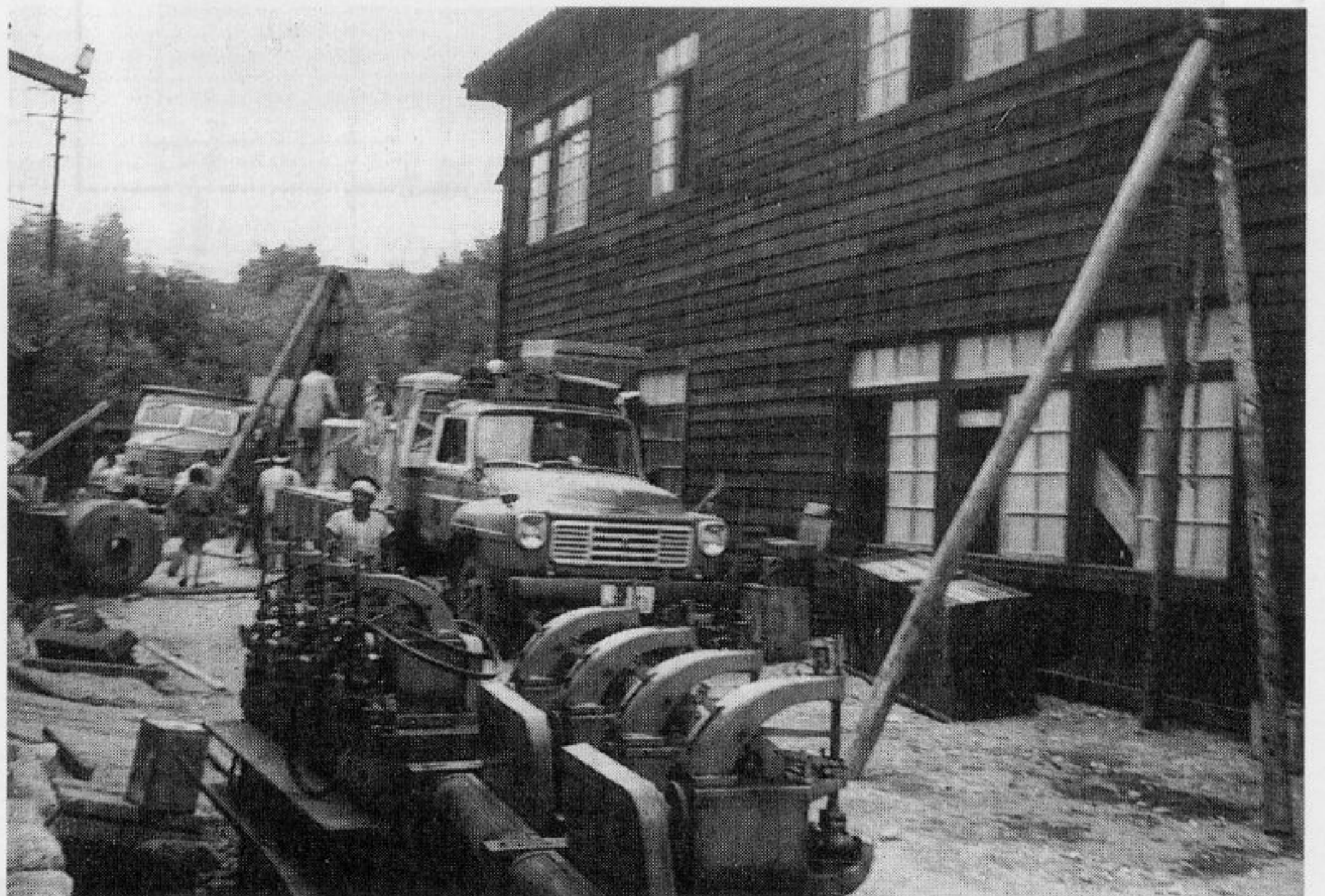
移築された校舎の中へ糸巻き機の搬入
