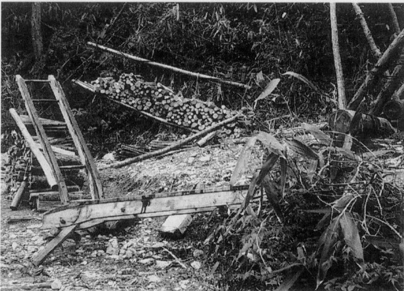
山からの荷下ろし的手段として使用された「架線」と「木馬」
