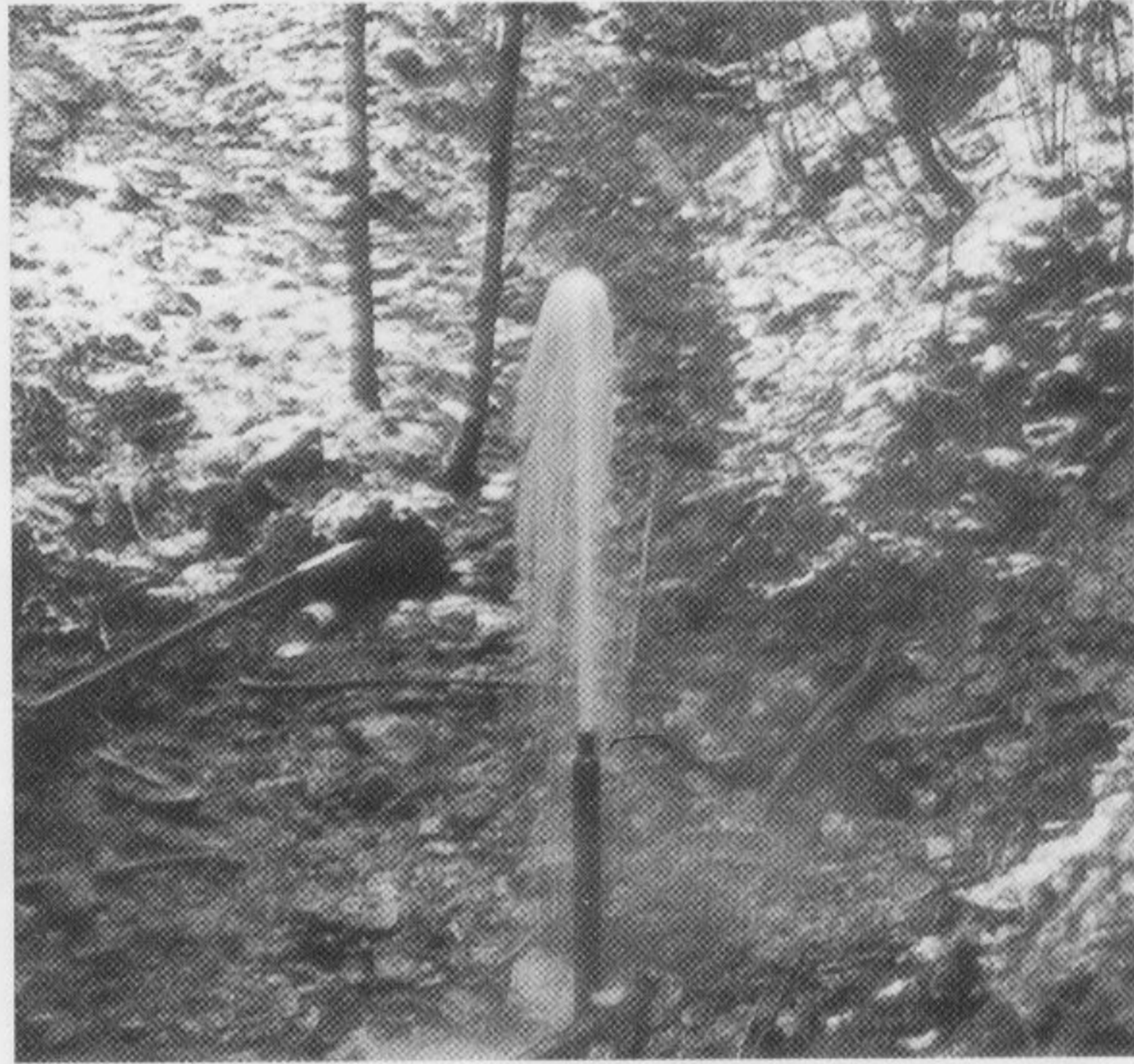
湯が洞で噴出した昼神温泉一号井 掘削深度40.2m 湯温36度 噴出量190ℓ/分 (昭和48年12月5日 牛山忠人氏 撮影)
