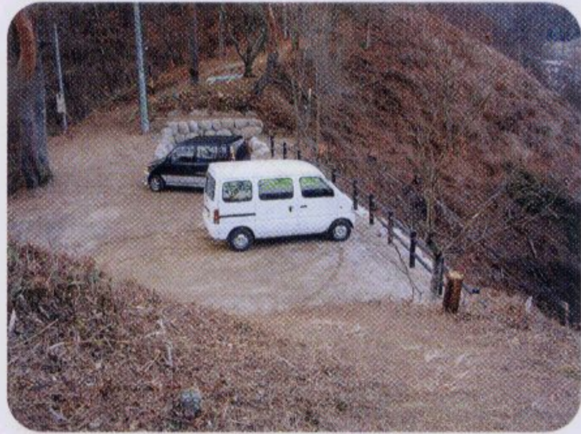
整備された駐車場
