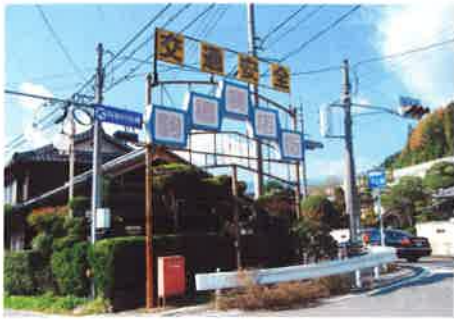
撤去した商店街案内看板
